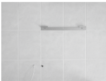
A készülék felszerelésének előkészítése: konzol, kondenzvíz elvezető cső és elektromos hálózatra való csatlakozás.
