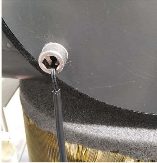
T4 – Kompresszorkimenet hőérzékelője
