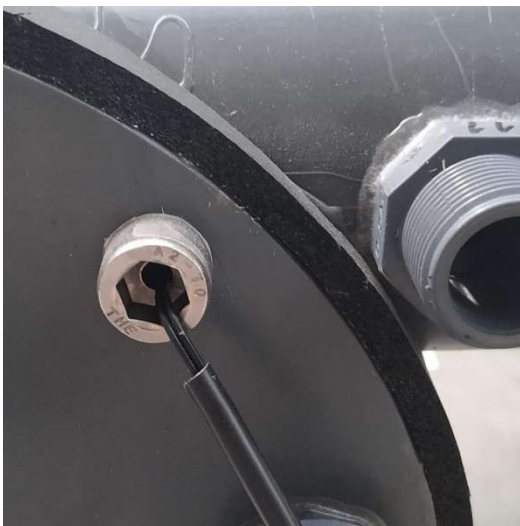
T5 – Vízkimenet hőérzékelője
